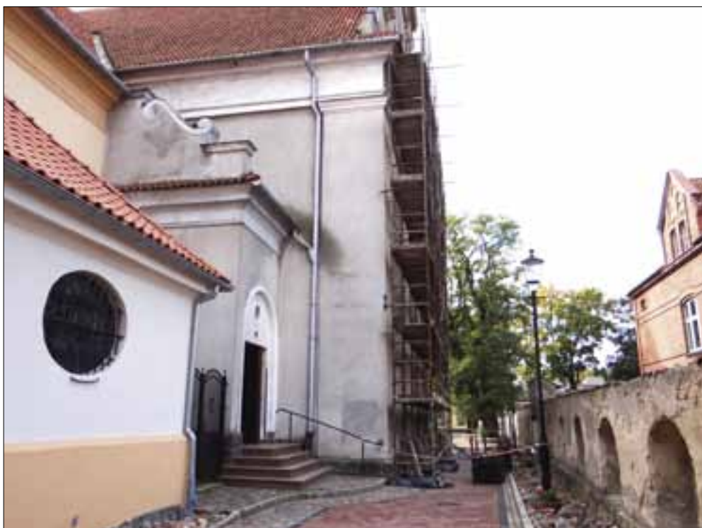
W tym roku kontynuowany jest remont elewacji kościoła Trójcy Świętej w Wejherowie. Prace będą trwały ok. dwa miesiące.
